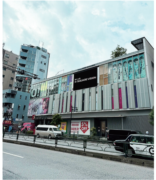
新大久保K-SQUAREVISION設置箇所全景
